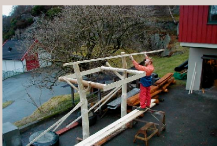
Montering på forhånd for å tilpasse alle delene.
