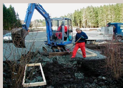
Fundamentet til ca 1 m 3 betong blir utgravd.
