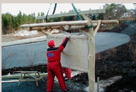
Finerplaten blir montert.
