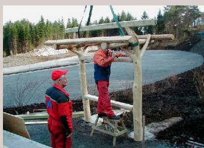
Fundamentet er støpt og tavlen blir montert.
